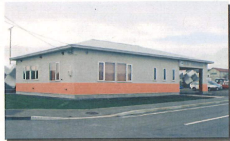
白老港港湾管理事務所
